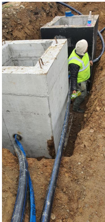
Extindere alimentare cu apă și cămin de aerisire, sat Poderei, com. Rebrișoara
