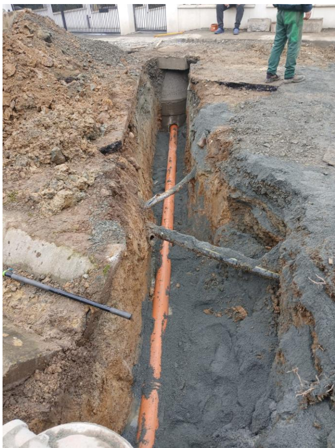
Extindere canalizare, cartier Lușca, oraș Năsăud
