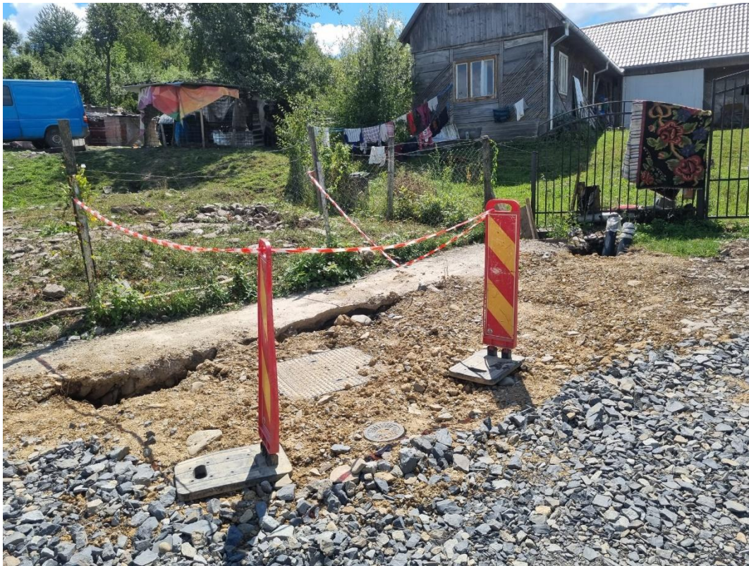
JOSENI BÂRGĂULUI – extindere apă și canalizare
