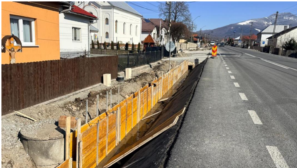
com. Tiha Bârgăului - branșamente apă și racorduri canal - 03.03.2026
