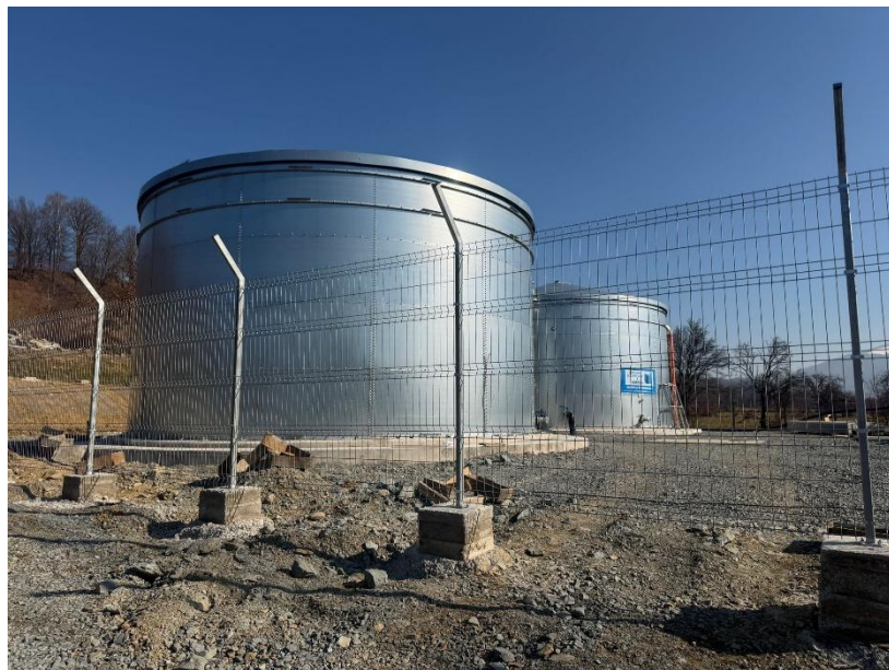
Gospodărie de apă Tiha Bârgăului - 2 rezervoare - 03.03.2026
